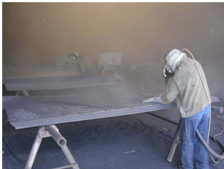
Figura 41 – Operação de jateamento das amostras
