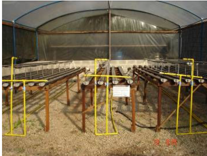
Figura 4.8 - Sistema hidropônico NFT da ETE - UFES
