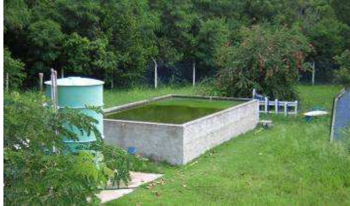
Figura 8 – Antigo sistema RAC + Lagoa de polimento.
