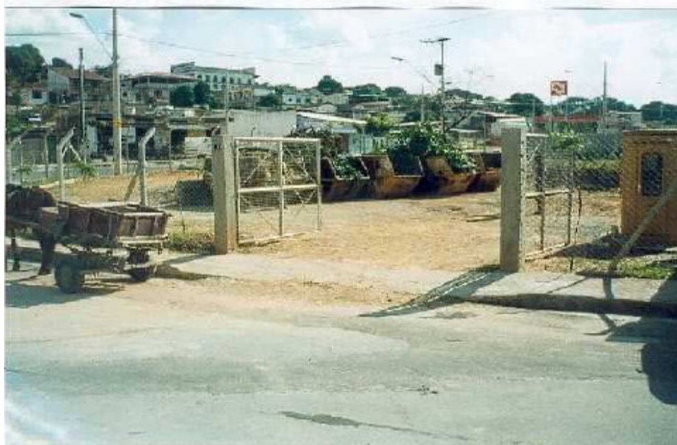
Figura 3.8: Unidade de Recebimento “Saramenha” em Belo Horizonte - MG
