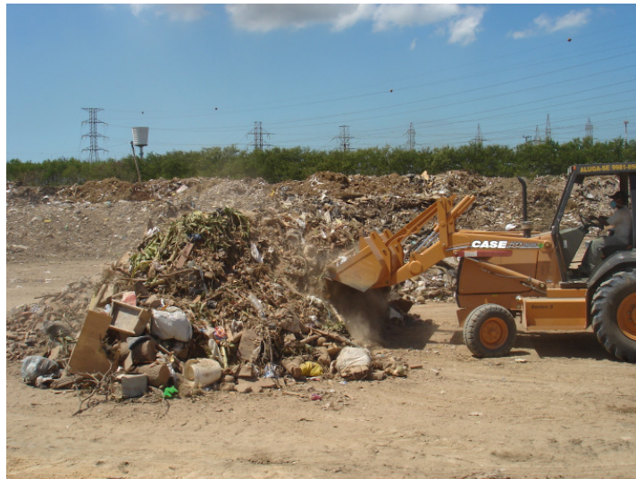
Figura 4.3: Homogeneização de pilha de ENTUV-ES para posterior quarteamento
