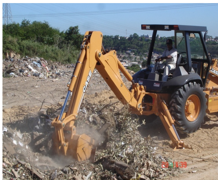
Figura 4.4: Quarteamento de pilha de ENTUV-ES depois de homogeneizada
