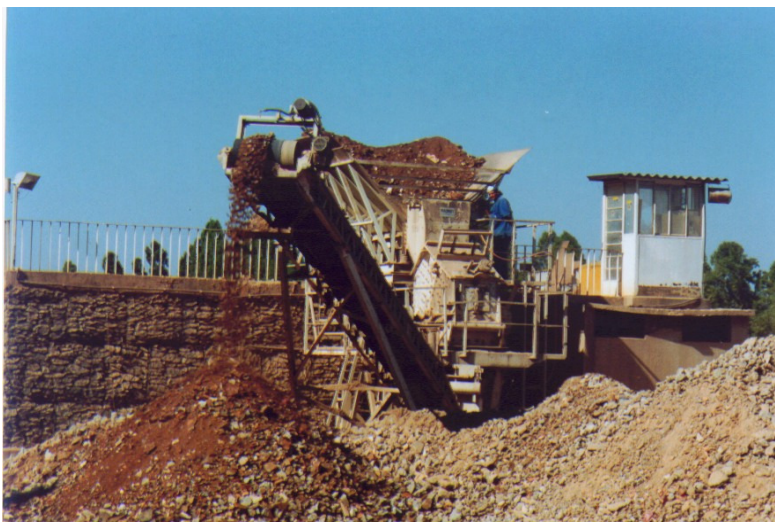
Figura 3.10: Correia transportadora utilizada no beneficiamento de RCC's de Classe A Fonte: arquivo técnico da empresa Marca Ambiental
