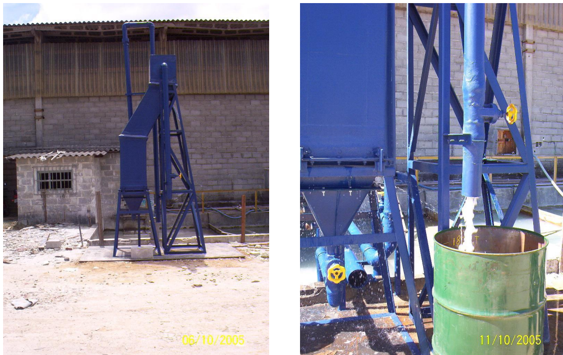
Fig. 4.1. Decantador utilizado e efluente coletado em tambor graduado.
