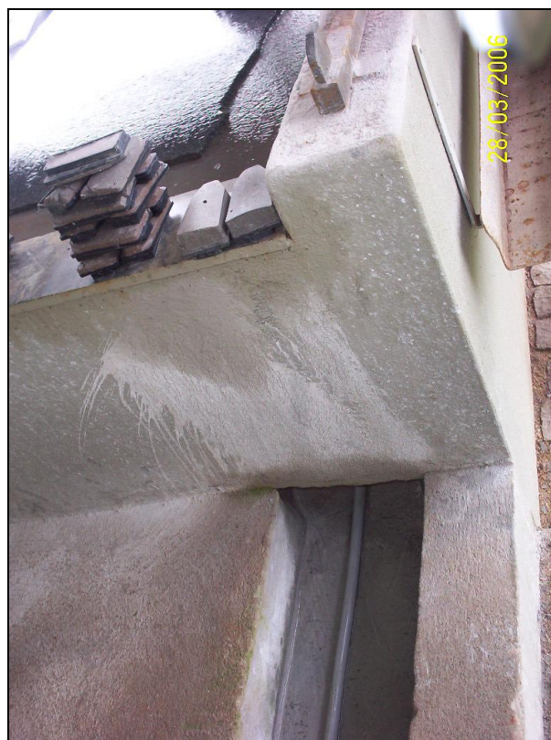
Fig. 3.8 – Canaleta de saída do efluente das politrizes.
