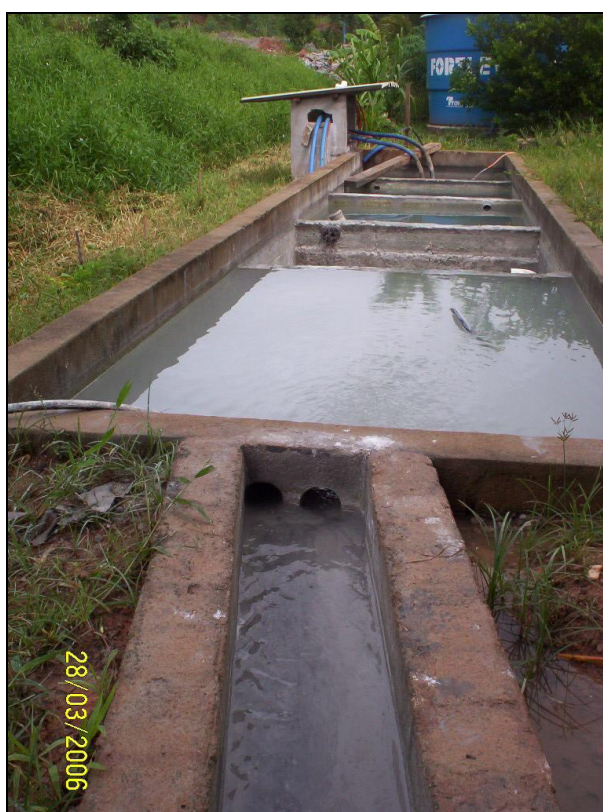
Fig. 3.10.- Sistema típico de sucessivos tanques de decantação para sedimentação dos sólidos dos efluentes.
