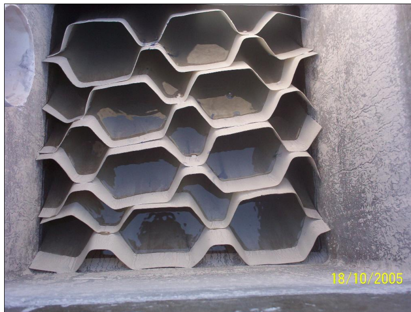
Fig. 4.3. Lamelas no interior do decantador
