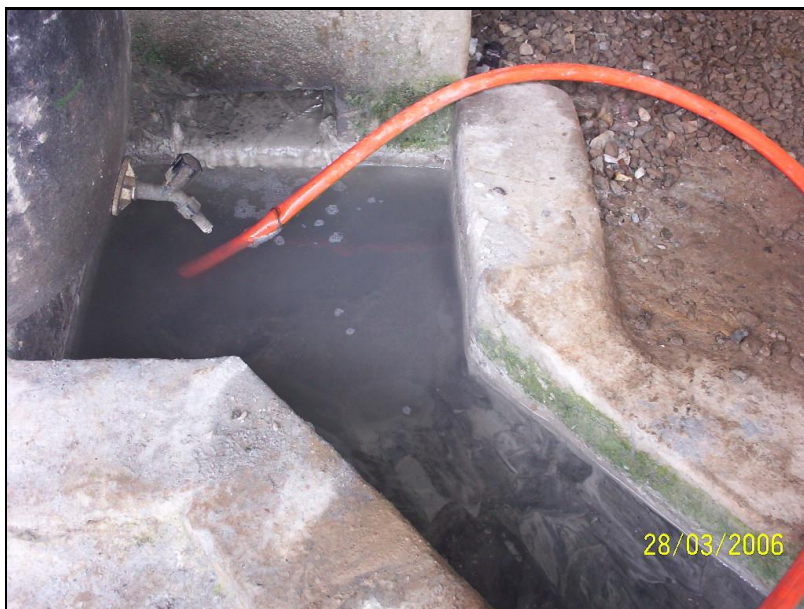
Fig. 3.9. – Sistema de adição do polímero ao efluente (balde e torneira).
