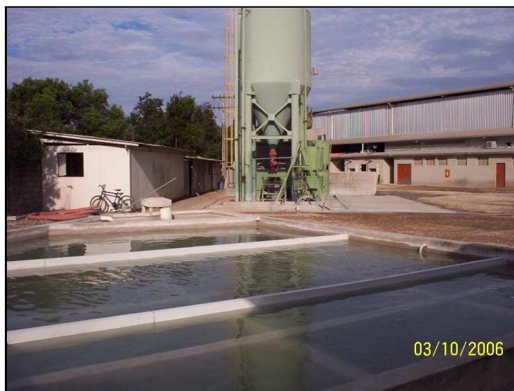
Fig. 3.13. – Decantadores verticais e tanques de água de reuso.
