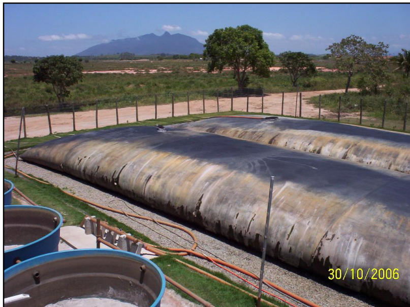
Fig. 3.18. – Bolsas filtrantes em operação.
