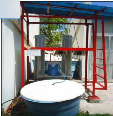
Figura 4.11 - Vista Geral do Sistema
