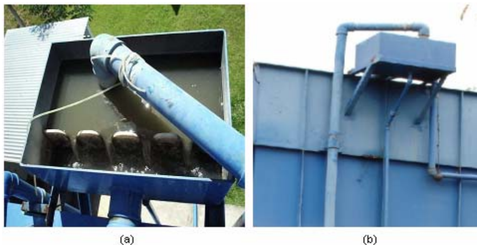
Figura 15 - Caixa de areia da ETE-UFES: (a) Vista superior com os vertedores em destaque; (b) Vista lateral. Fonte: Sá, (2004).
