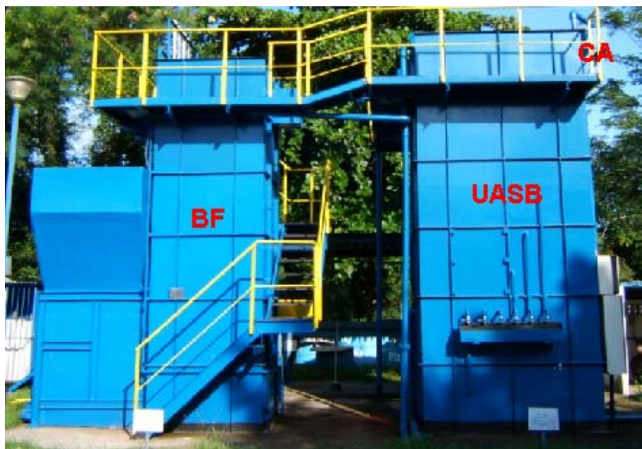
Figura 13 - Foto da ETE-UFES.
