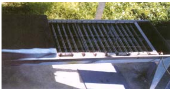
Figura 21 - Reator UV com lâmpadas emersas da ETE-UFES.
