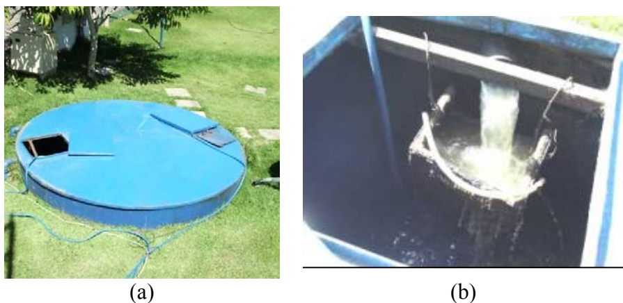
Figura 14 - Estação elevatória da ETE-UFES: (a) Vista superior; (b) Foto do esgoto afluyente escoando por uma grade que retém os sólidos grosseiros.
