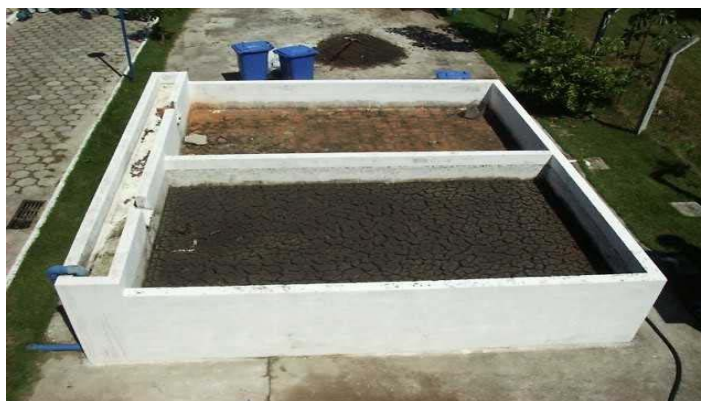
Figura 22 – Leito de secagem da ETE-UFES.
