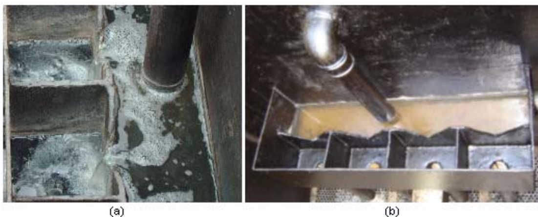
Figura 18 - Fotos da CDV: (a) Com o fluxo de esgoto pelos vertedores; (b) Sem fluxo de esgoto.
