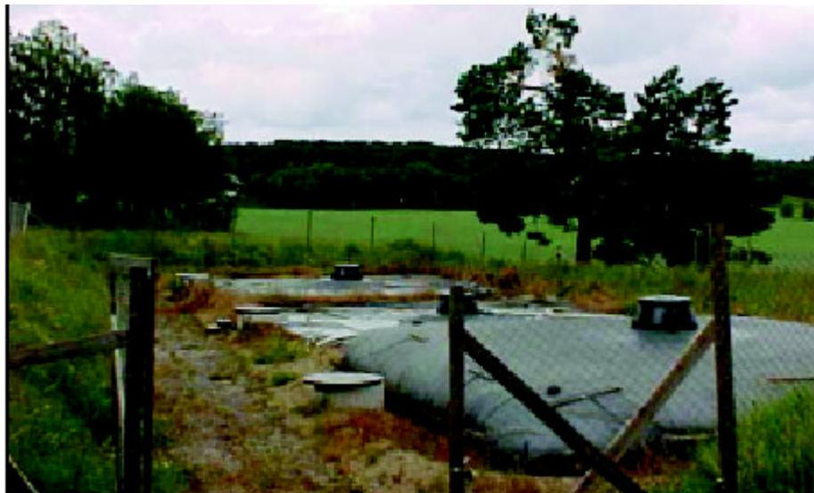
Figura 3- 10: Tanques de estocagem de urina.
