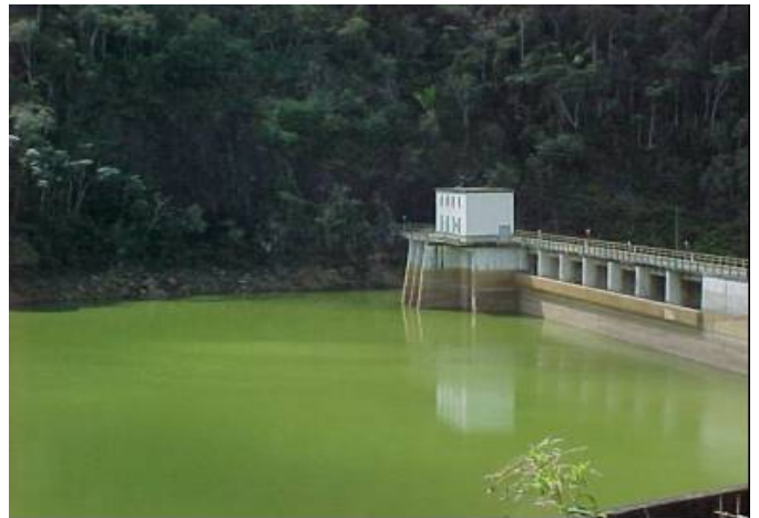
Figura 9: Barragem da Represa Rio Bonito
