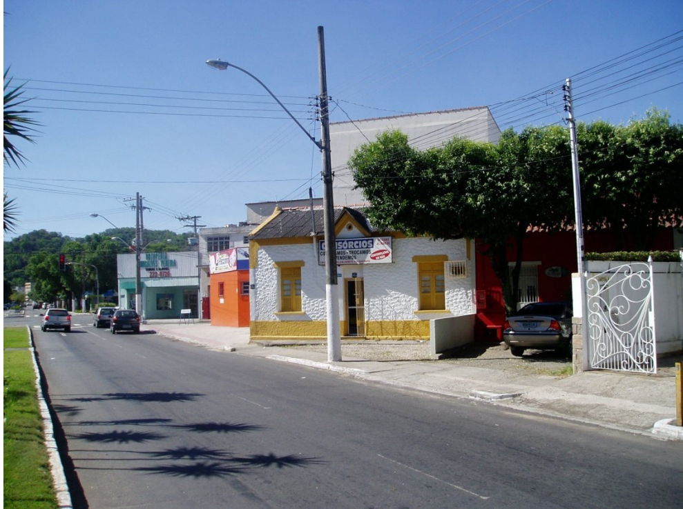
Destaque para as casas: branca com detalhes em amarelo e vermelha - as duas que restaram da Rua Antonieta Tatagiba. Foto de arquivo pessoal
