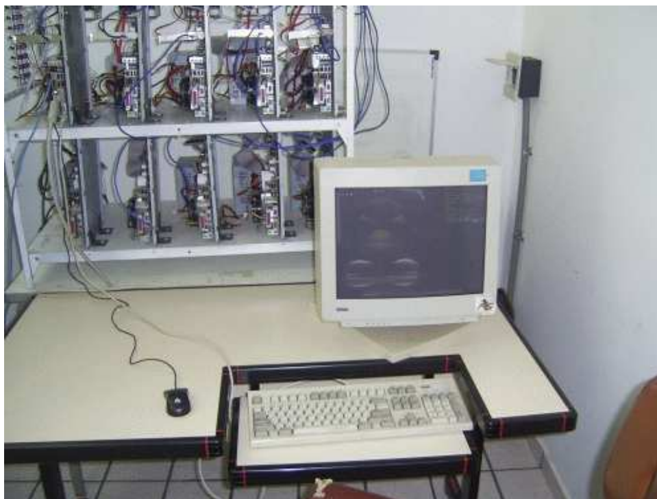
Figura 3.1: Cluster destacando a estação para operação local.
