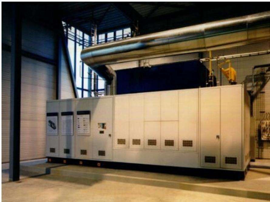
**Figura 2.11.** Vista externa de uma SOFC de 100kW *Siemens-Westinghouse* (SOUZA, 2009).
