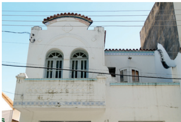
Fig. 55. Edificação à Rua Muniz Freire, nº. 43. Fonte: www.secult.es.gov.br
