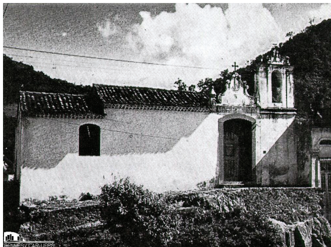
Fig. 48. Fachada principal da capela de Santa Luzia, década de 70. Fonte: Prefeitura Municipal de Vitória.
