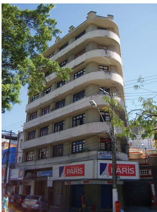
Fig. 58. Entre as edificações consideradas como de qualidade construtiva, destaca-se o edifício Antenor Guimarães, primeiro prédio construído em Vitória. Fonte: Acervo pessoal da autora.
