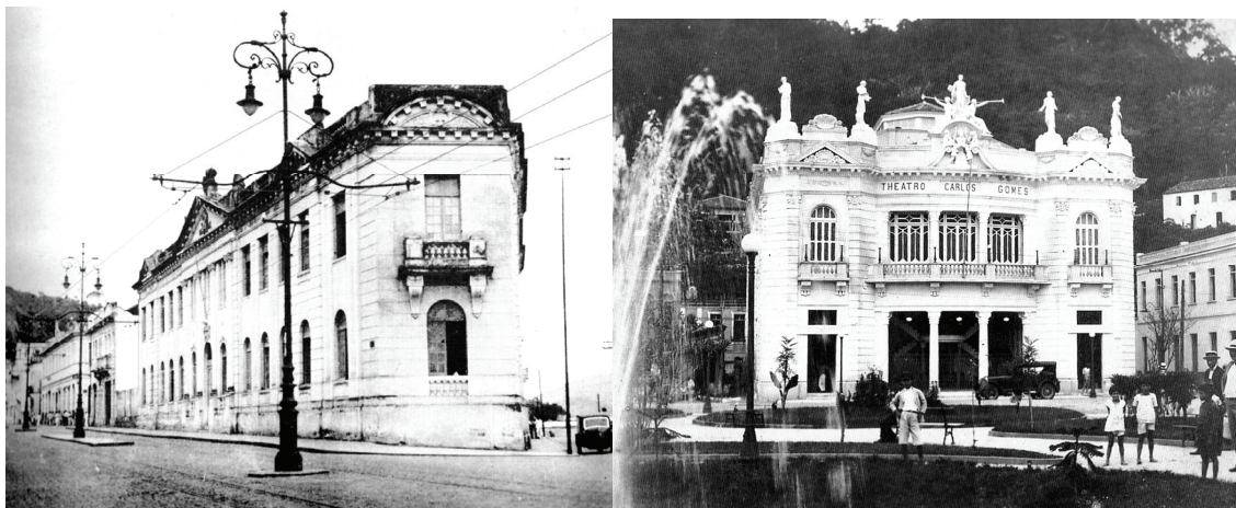
Fig.13 e 14. Edificações construídas durante o governo Florentino Avidos, ambas de influência eclética. À esquerda, o Grupo Escolar Gomes Cardim (atual FAFI), localizado na Av. Capichaba. À direita, Theatro Carlos Gomes, na praça Costa Pereira. Fonte: Prefeitura Municipal de Vitória.
