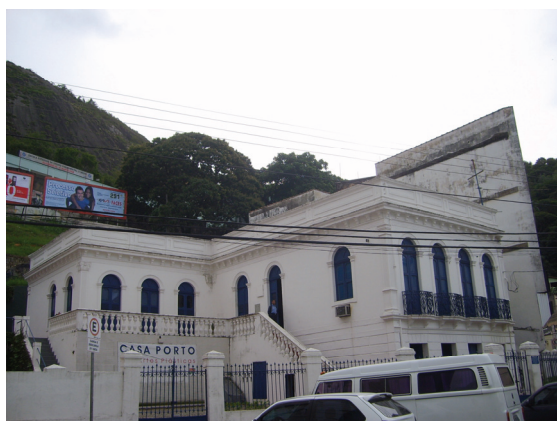
Fig. 56. Prédio da antiga Capitania dos Portos (hoje Casa Porto de Artes Plásticas), edificação considerada como de importante significação social pela PMV. Fonte: Acervo pessoal da autora.
