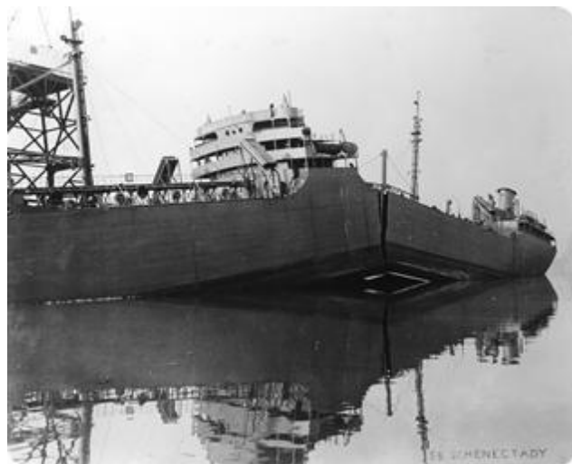
Figura 1 - Navio-tanque Liberty que se partiu de maneira súbita e frágil em 16/01/1943 [2].
