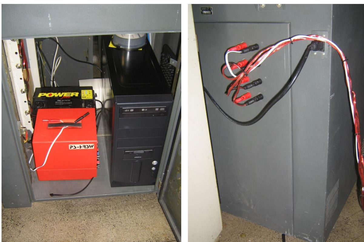
Figura 23 - Interior e parte traseira do CAAD.
