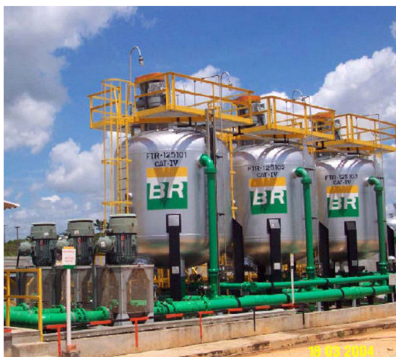
Figura 3.7: Planta de reinjeção de água produzida localizada em Carmópolis - Sergipe.
