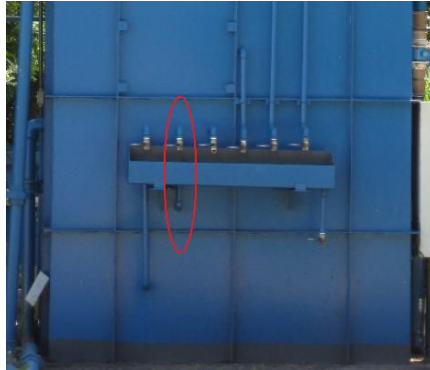
Figura 4.4: Vista frontal do reator UASB, com destaque para a torneira 2, situada a 0,75 metros do fundo.
