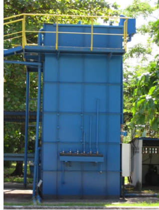
Figura 4.3: Reator anaeróbio de fluxo ascendente com manta de lodo - UASB (Upflow Anaerobic Sludge Blanket).
