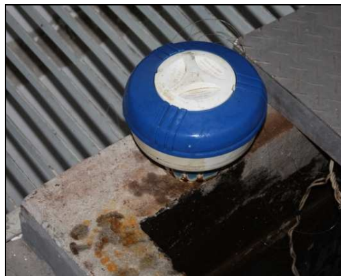
Figura 26: Clorador de pastilhas
