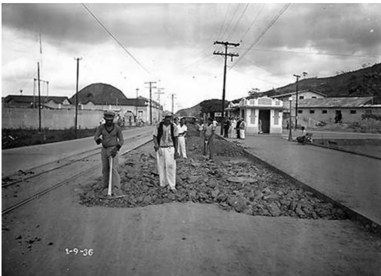
Fotografia 9 - Obras na Av. Vitória. No canto esquerdo da imagem, é possível observarmos a linha dos bondes. 1936. PMV.
