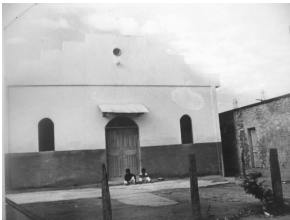
Foto 16: Capela da Comunidade Nossa Senhora Aparecida - 1986
