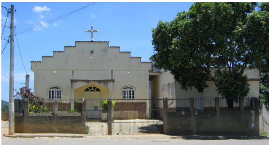
Foto 17: Capela da Comunidade Nossa Senhora Aparecida – 2007.
