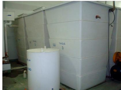
**Figura 2: ETAC em escala real instalada na edificação**
