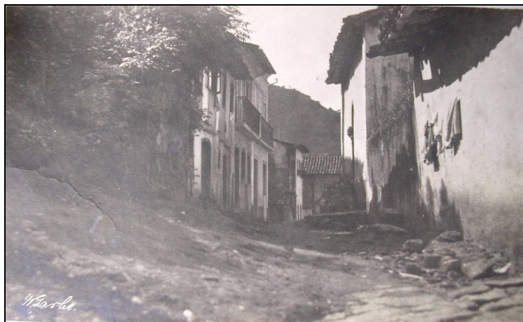
Figura 10 – Rua do Chafariz em Vitória, primeira década do século XX Fonte: IPHAN.
