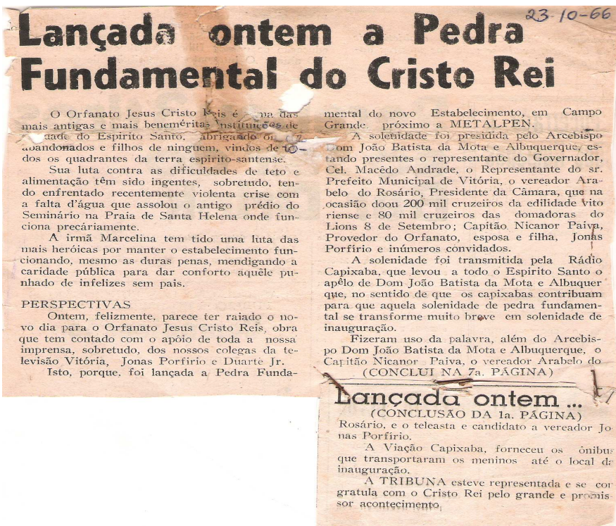
Foto 6. Começa a construção da futura sede do Orfanato Cristo Rei. Fonte: Jornal A Tribuna, de 23/10/1966
