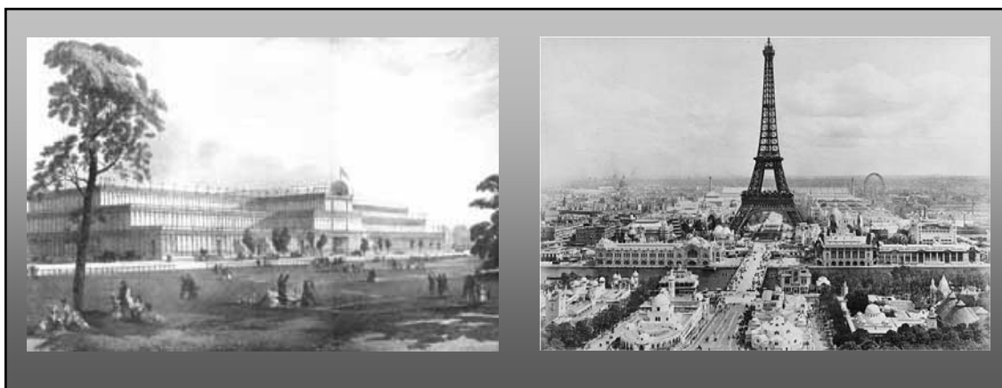
FIGURA 6: Exemplos de Obras em Londres e Paris
