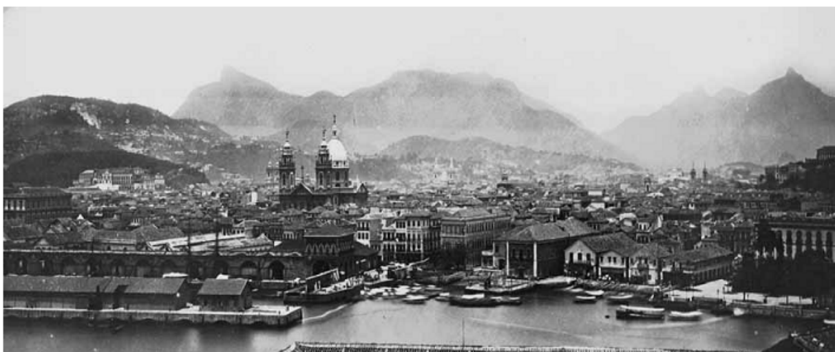
FIGURA 4: Rio de Janeiro, 1890 Panorama da área central do Rio de Janeiro, tomado da ilha das Cobras, c. 1890. Fonte: Marc Ferrez
