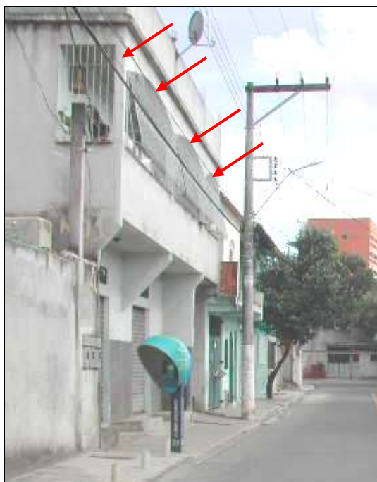
FIGURA 28 - SOBRADO COM VARANDA GRADEADA NO BAIRRO SÃO PEDRO
