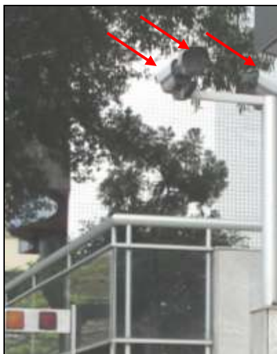
FIGURA 50 - CÂMERAS DE SEGURANÇA EM UM CONDOMÍNIO DO BAIRRO PRAIA DO CANTO Fonte: Acervo fotográfico (2009)
