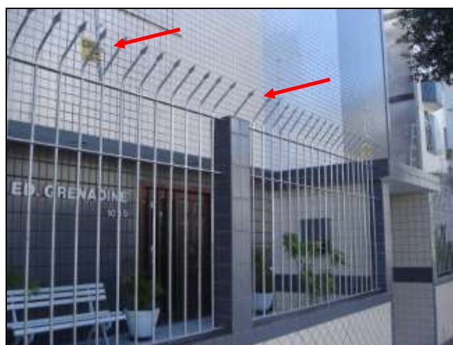
FIGURA 44 - COMBINAÇÃO DE LANÇAS E CERCA ELÉTRICA EM UM CONDOMÍNIO DO BAIRRO JARDIM CÂMBURI
