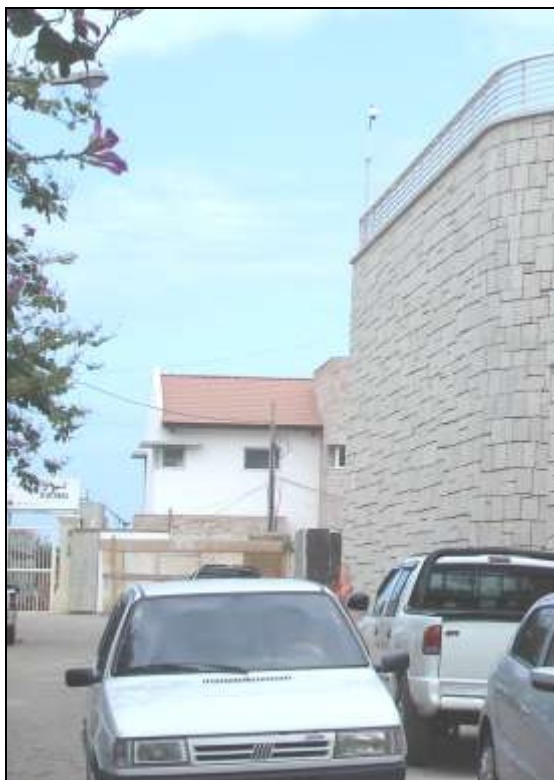
FIGURA 33 - MURO FEUDAL DE UMA RESIDÊNCIA DO BAIRRO ILHA DO BOI
