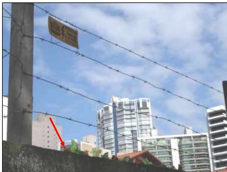
FIGURA 36 - MURO COM CACOS DE VIDRO EM UMA RESIDÊNCIA DO BAIRRO ENSEADA DO SUÁ
