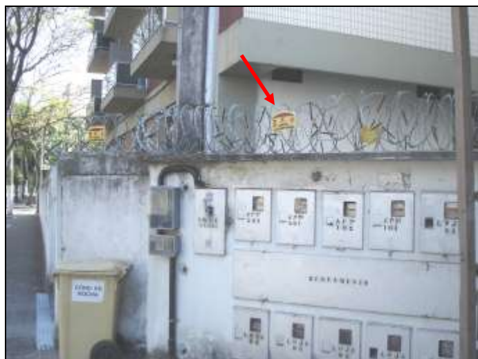
FIGURA 41 - COMBINAÇÃO DE CERCA ELÉTRICA E ROLOS DE ARAME FARPADO EM UM CONDOMÍNIO DO BAIRRO JARDIM DA PENHA
