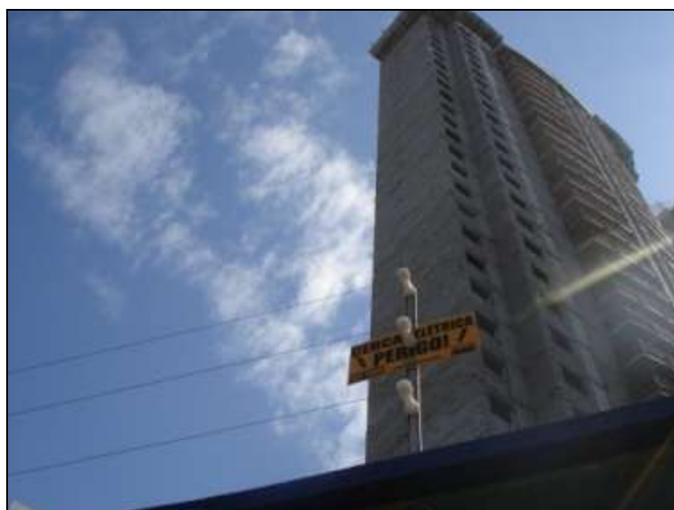
FIGURA 51 - CERCA ELÉTRICA EM UMA CONSTRUÇÃO DO BAIRRO ENSEADA DO SUÁ Fonte: Acervo fotográfico (2009)
