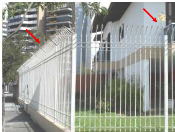
FIGURA 42 - COMBINAÇÃO DE LANÇAS E CERCA ELÉTRICA EM UMA CASA DO BAIRRO ENSEADA DO SUÁ
