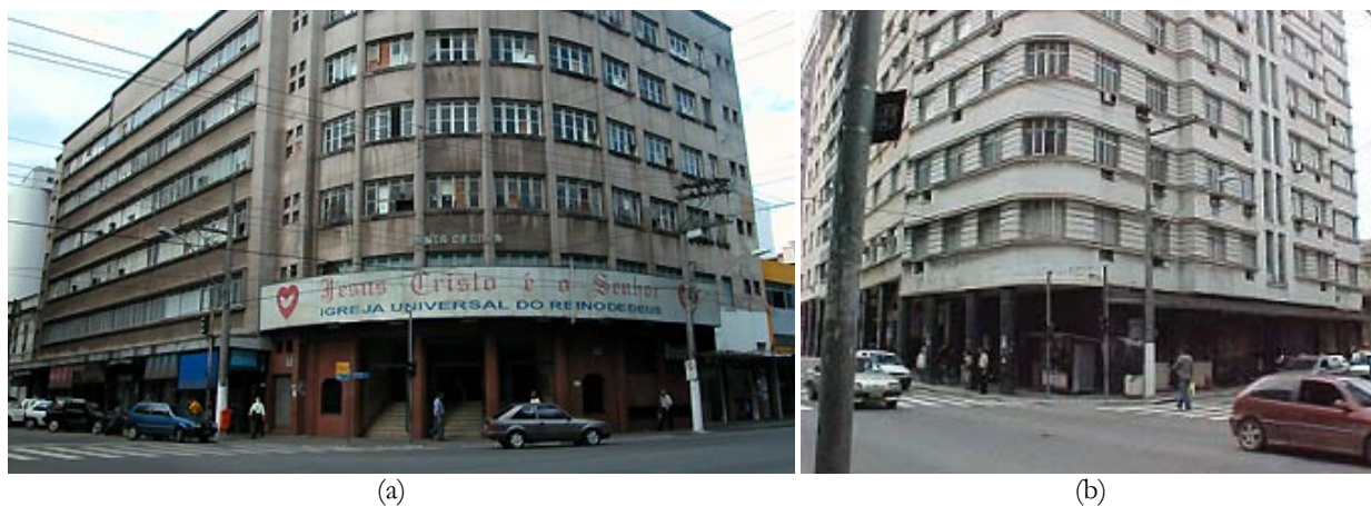
Figura 21: Edifícios a serem reabilitados na próxima fase do Programa Morar no Centro: (a) Edifício Santa Cecília; (b) Edifício José Lourenço Costa Aragão (200?)
