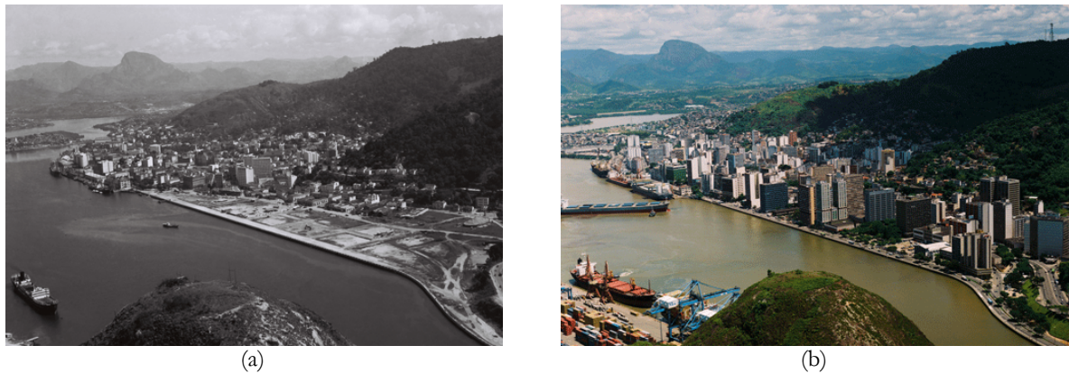
Figura 7: (a) Aterro da Esplanada Capixaba (1960) - Paulo Bonino; (b) Centro de Vitória (2004) - Davi Protti Fonte: GALERIA Vitória em dois tempos, PMV.
