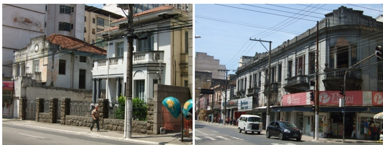
Figura 13: Edificações vazias e subutilizadas no Centro de Vitória (2009)
