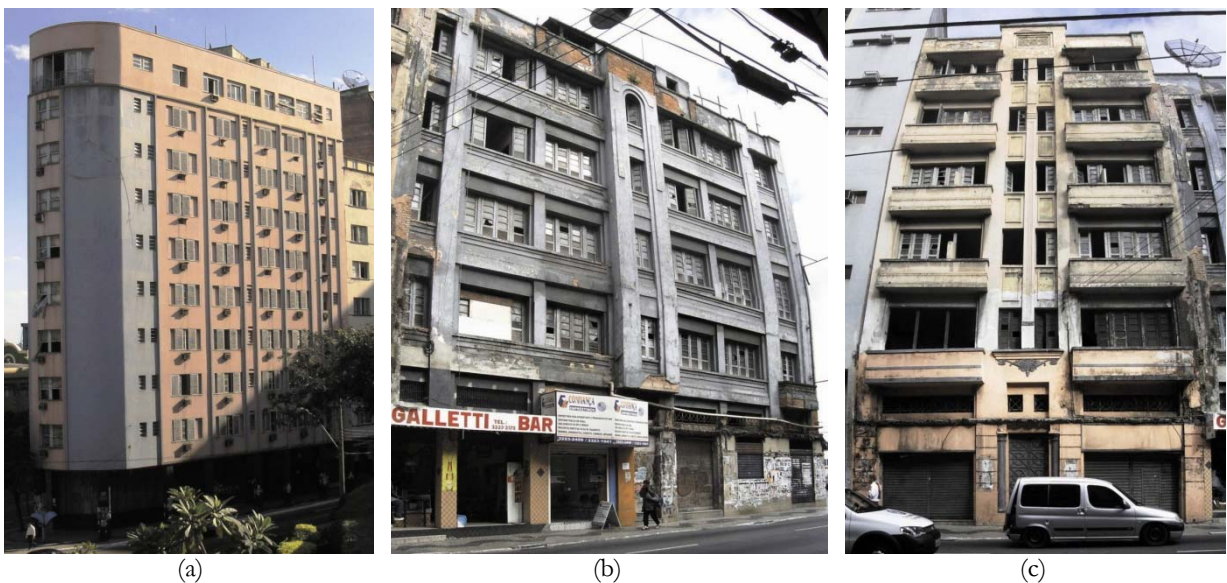
Figura 20: Edifícios em reabilitação na primeira fase do Programa Morar no Centro: (a) Ed. Estoril; (b) Ed. Pouso Real; e (c) Ed. Tabajara (200?).
