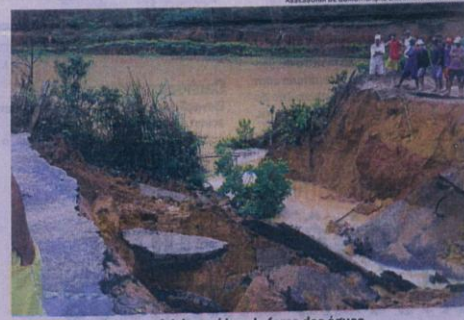
TRECHO de asfalto que foi destruído pela força das águas
