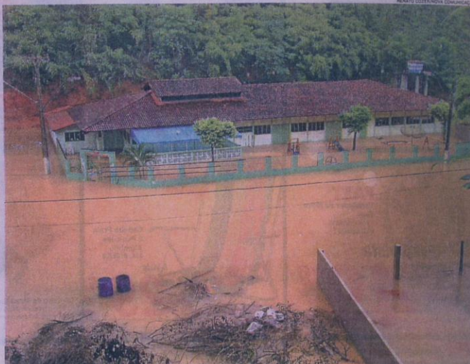
ESCOLA amanheceu tomada pela água em Santa Leopoldina, depois de uma noite inteira de chuva no município
