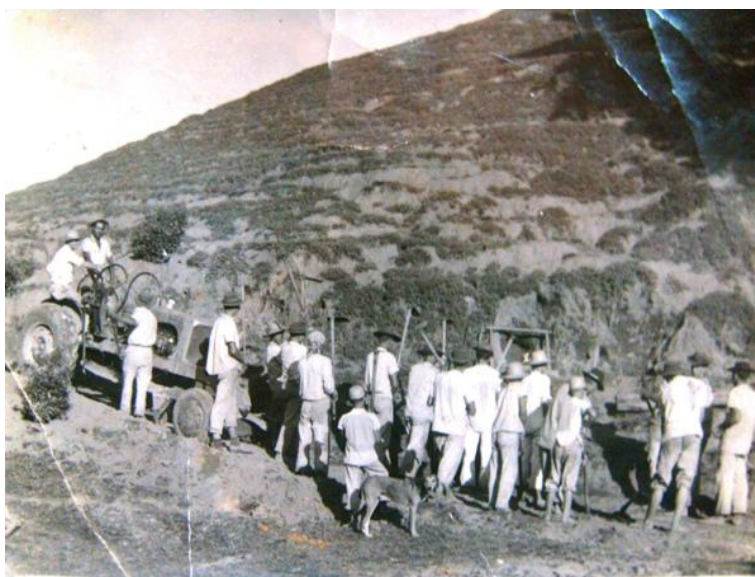
Figura 95: Mutirão para abertura de estrada, em Santa Leopoldina – data e autor não identificados 67
