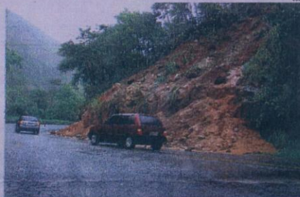
BARREIRA deslizou no km 30 da BR-262, por causa das chuvas na região
