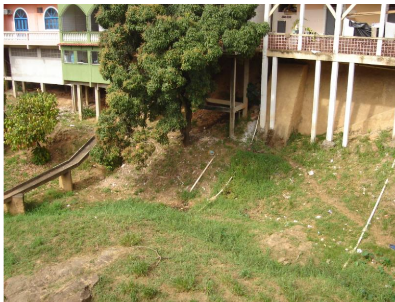
Figura 127: Esgoto eliminado diretamente no rio, por uma edificação mais no interior da área urbana Fonte: Arquivo pessoal, 2009.
