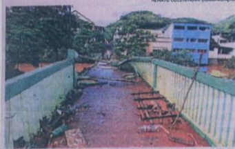
PONTE no centro de Santa Leopoldina ficou destruída após enchente que atingiu município
