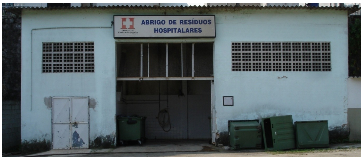
Figura 14: Foto do abrigo de resíduos sólidos do HUCAM.
