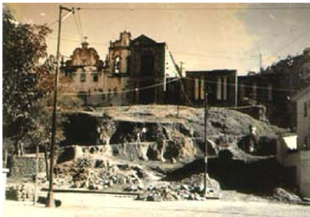
FIGURA 28 – Ruínas e novas construções. Convento de São Francisco. s/d. Arquivo Público Municipal de Vitória.
