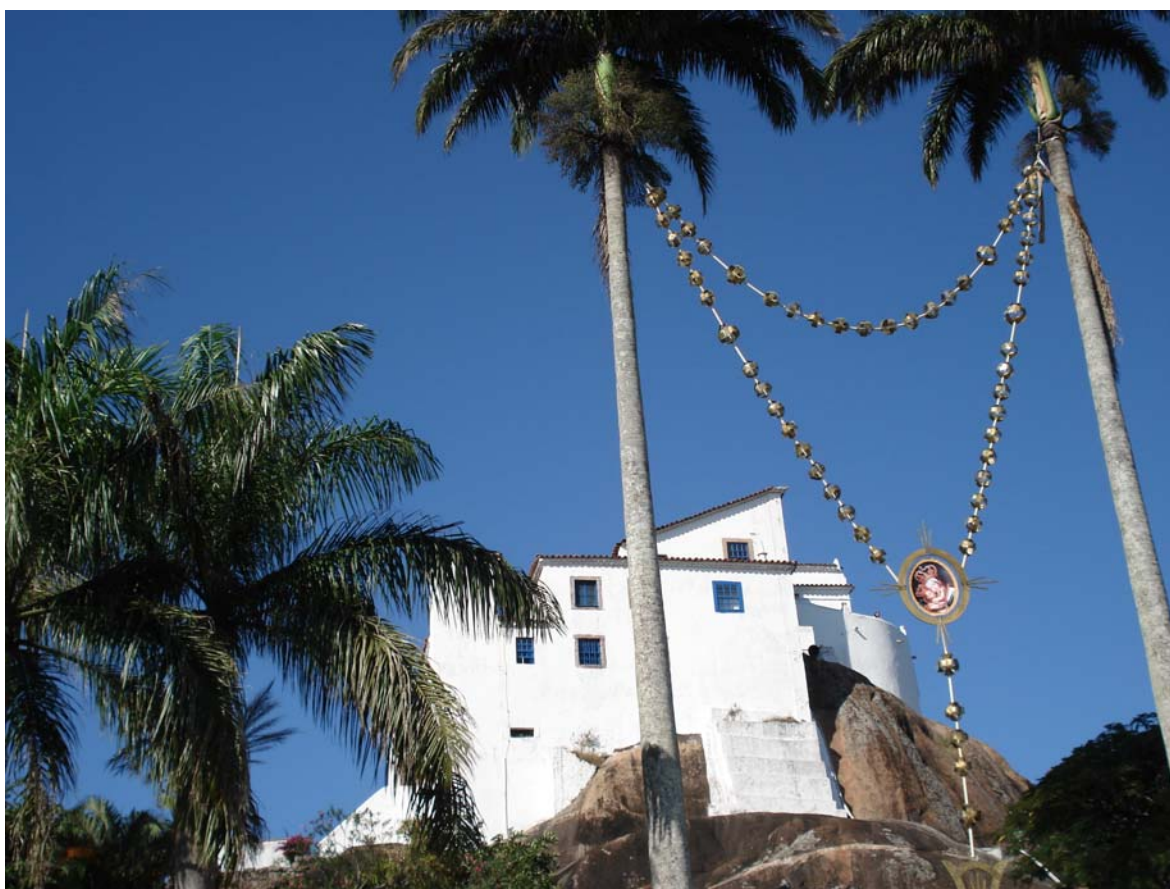
FIGURA 2 – Convento de Nossa Senhora da Penha. 2008. Fotografia da autora.
