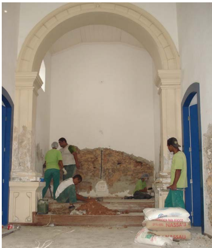
FIGURA 152 – Capela de Nossa Senhora das Neves em obras. Dezembro de 2008. Fotografia da autora.
