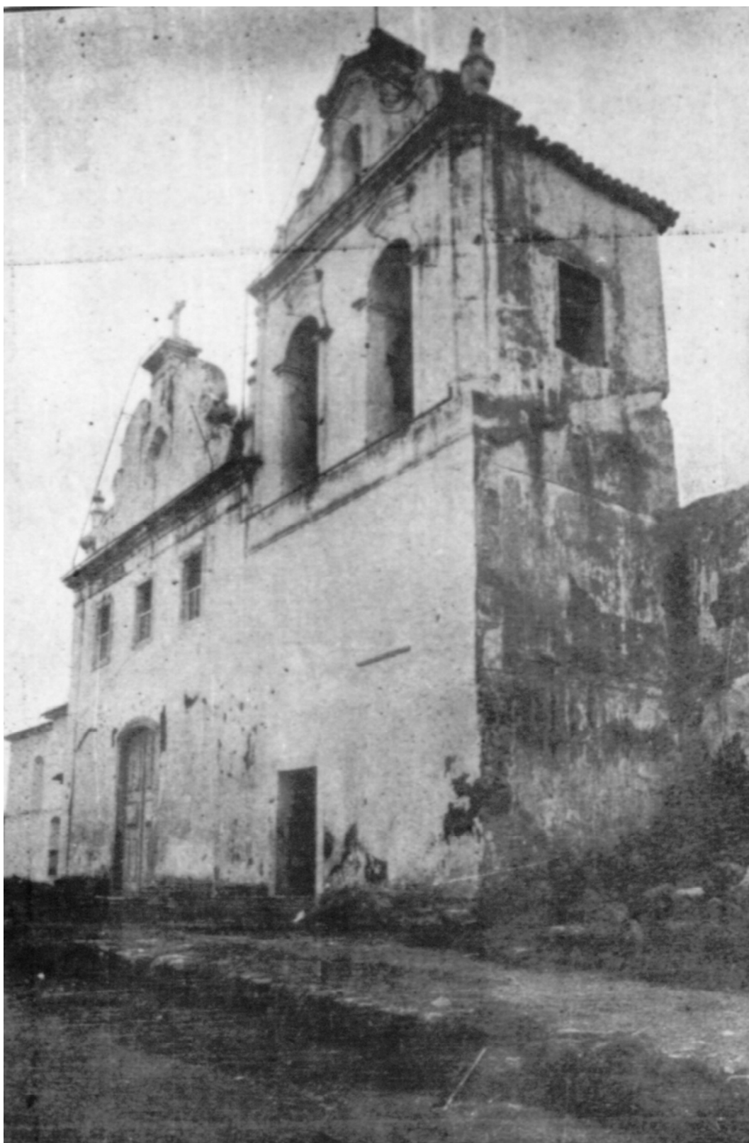
FIGURA 25 – Antiga torre sineira e fachada da igreja conventual de São Francisco. s/d. Fotografia: Frei Taciano Cetaro. SPHAN-RJ.
