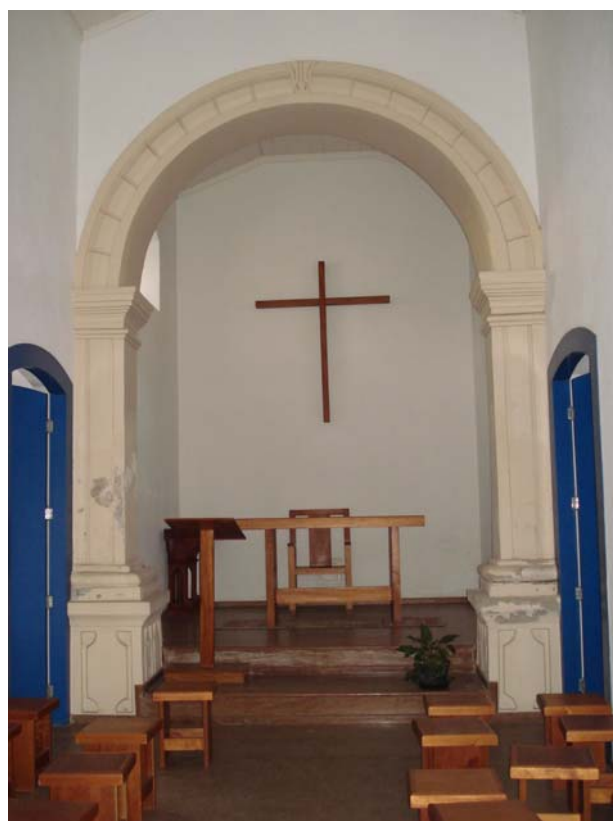
FIGURA 151 – Capela de Nossa Senhora das Neves restaurada. 2008. Fotografia da autora.
