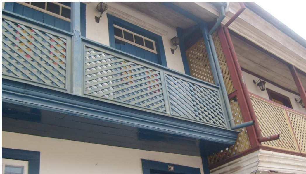
Figura 43 – Muxarabias em construções de Ouro Preto
