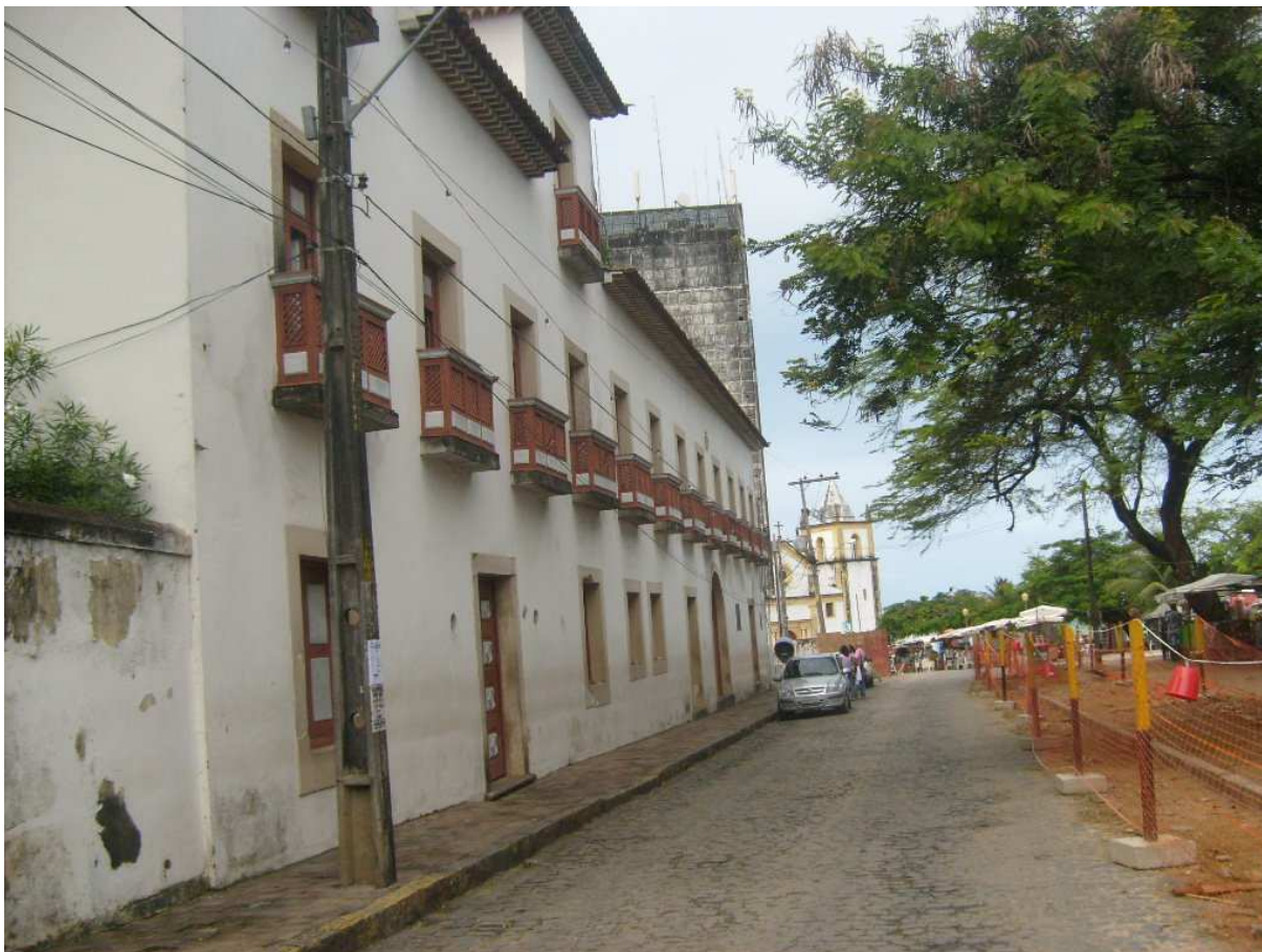
Figura 5 – Vista 3, Rua Bispo Coutinho
