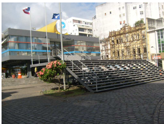
Figura 48 – Vista da chegada do Elevador Lacerda, ao fundo o edifício do Bradesco e as edificações do Portal da Misericórdia
