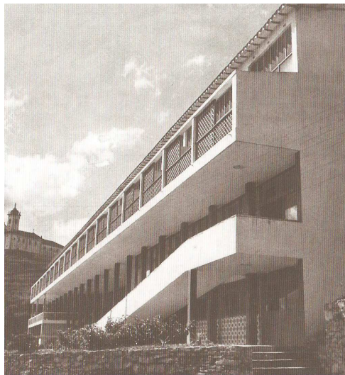
Figura 31 – O Grande Hotel Ouro Preto ainda sem telhado nas varandas
