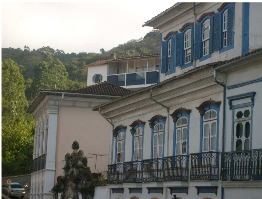
Figura 40 – Cores dos edifícios antigos e ao fundo o Grande Hotel
