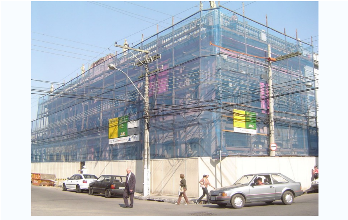
Figura 15. Programa Monumenta. Restauração em imóvel privado. Pelotas – RS. Disponível em: < http://www.monumenta.gov.br/site/wp-content/uploads/2008/11/2dario-miguel-lorenzi_durante.jpg >. Acesso em: 28/2/2010 21:34:07.
