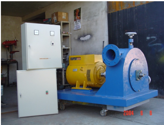
a) Grupo de geração com turbina tipo Pelton. (injetores, controle eletrônico de carga e união direta por meio de união flexível).
