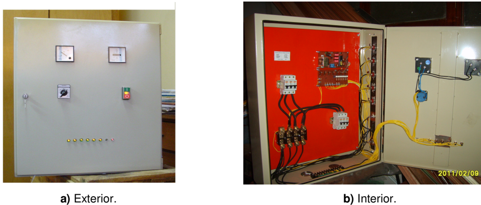
Figura 1.4 Controlador eletrônico de carga.
