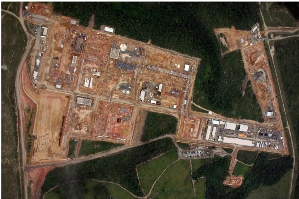
Figura 7: Vista aérea Construção da Unidade de Tratamento de Gás Sul Capixaba – UTG Sul, 2009.
