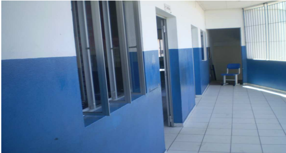
Figura 10- Corredor do primeiro andar visto a partir da escada da esquerda – observa-se que existe uma varanda (corredor de acesso) por onde sobrem duas escadas 56 .
