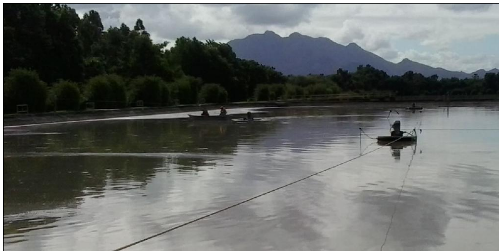
Figura 21 – Remoção dos aeradores na lagoa com a utilização de barco.
