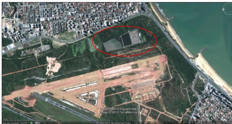
Figura 19 – ETE Camburi (vista aérea).
