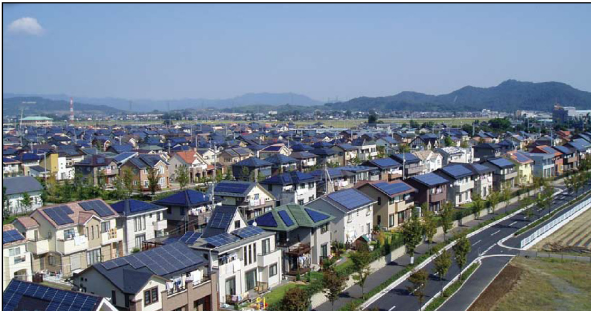
Figura 6 – Sistema distribuído conectado à rede na cidade de Otha no Japão. Fonte: EPIA, 2008 a .
