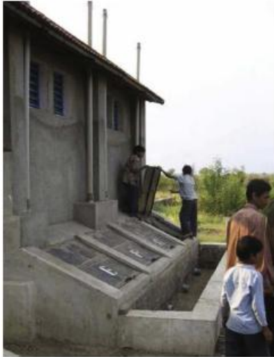
Figura 10: Câmaras do sanitário de desidratação das fezes (Fonte: ESF).
