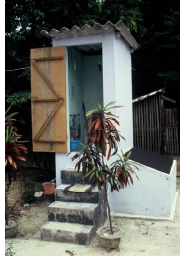
Figura 11: Sanitário desidratador de câmara dupla do Vietnã.
