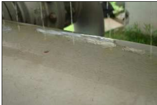
Fotografias 21, 22 e 23 – Cobertura e sistema de gotejamento de água para refrigeração do duto.
