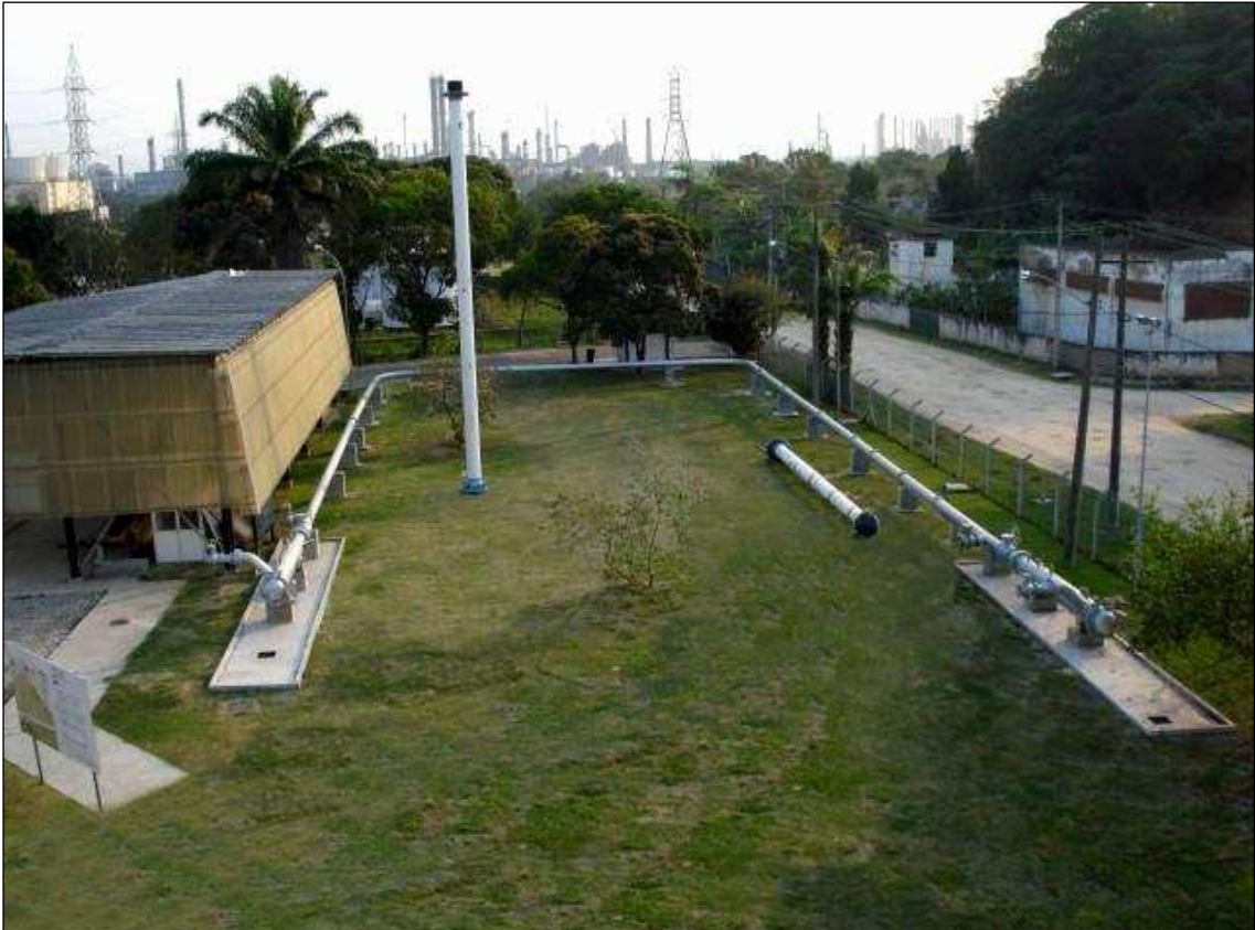
Fotografia 20 – Duto de 14” instalado no CTDUT.
