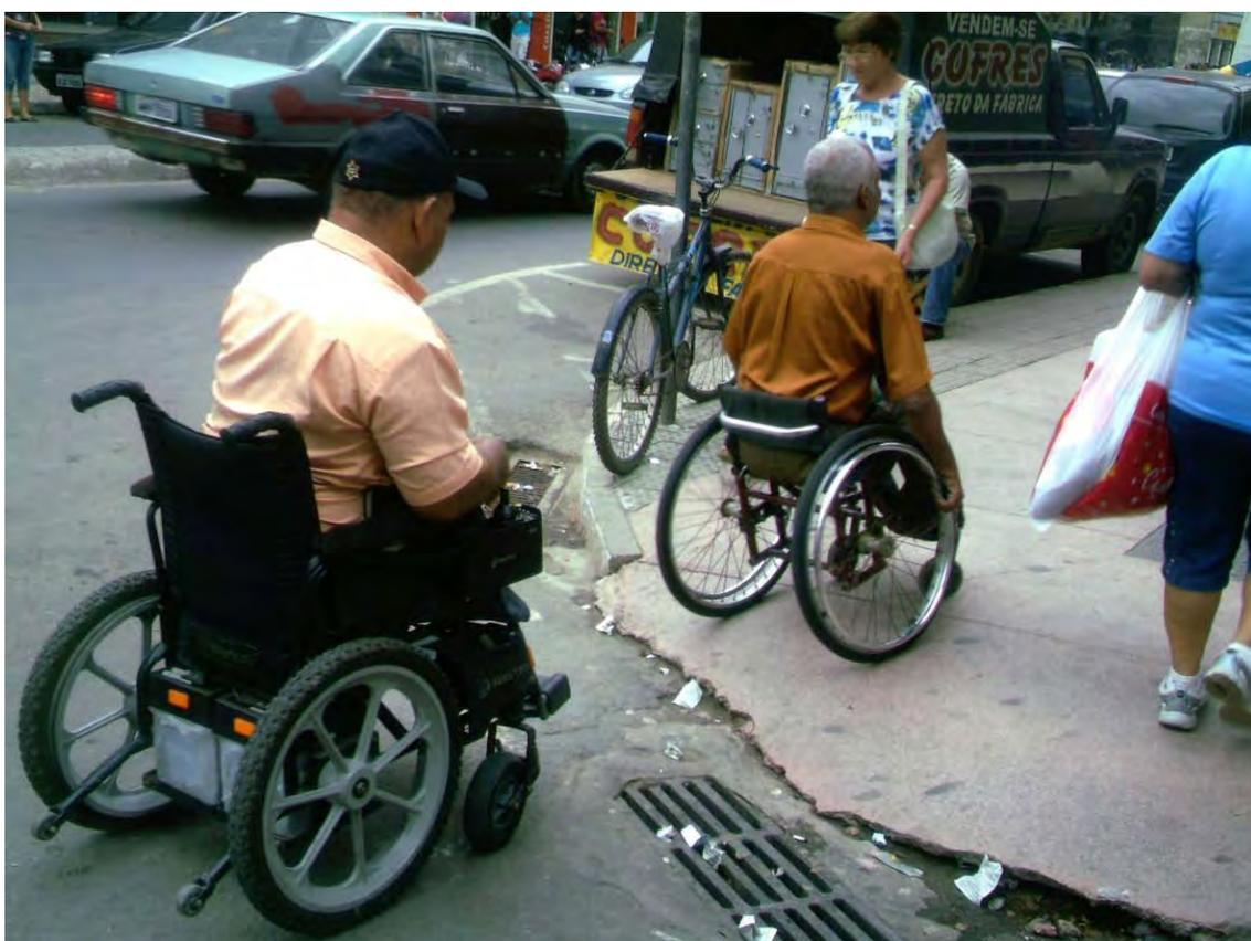
Figura 87: Trecho da Av. Expedito Garcia com acabamento de calçada mal executado.
