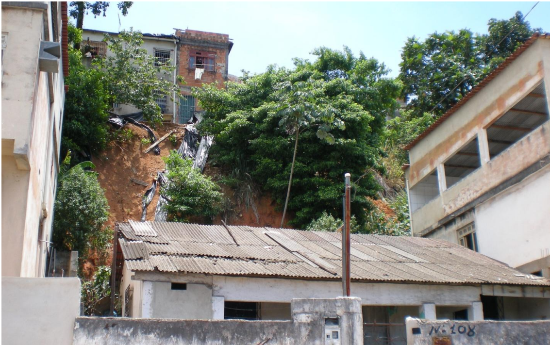
Figura 4: Residência em área de risco geológico na área conhecida como Barreira
