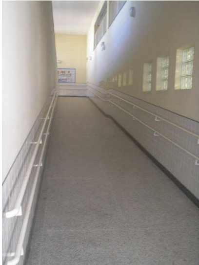
Foto 3: Primeira rampa de acesso ao segundo piso.
