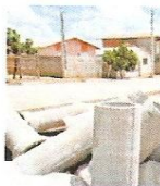
OBRA. Prefeitura trabalha na melhoria da infra-estrutura do conjunto Nova Conquista
