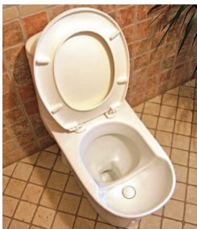
Figura 57: Bacia sanitária segregadora com caixa acoplada e com duplo acionamento de descarga. Fonte: MROZOWSKI (2011), mensagem pessoal.
