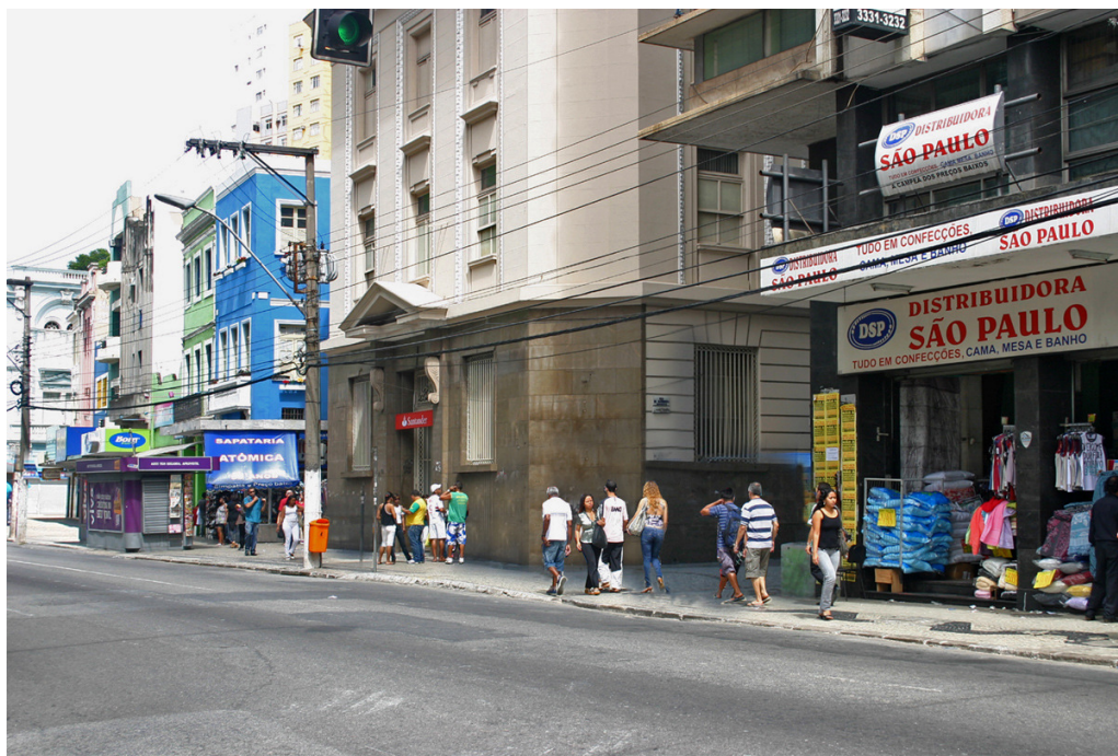
Figura 5.23 – Rua da Alfândega sem a presença dos ambulantes do Conjunto 1, em visada oblíqua à Avenida Jerônimo Monteiro. Esse momento permite a visualização integral de importante edificação do início do século passado. Fonte: Acervo do autor.
