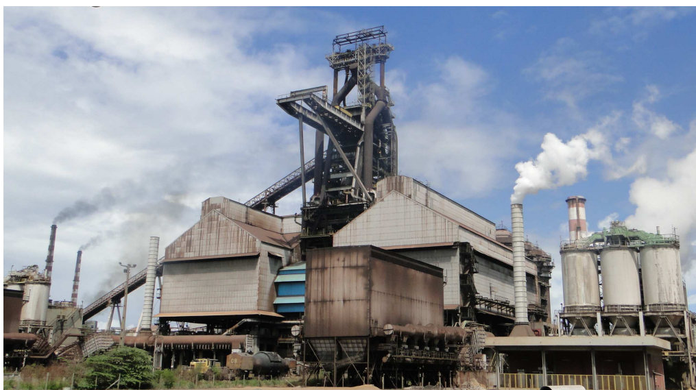
Figura 31: Visão panorâmica do Alto-Forno #1 da ArcelorMittal Tubarão.
