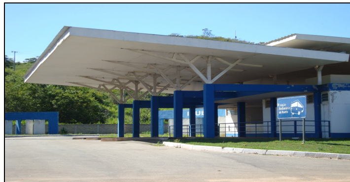
Figura 5: Terminal rodoviário inutilizado. Fonte: Priscila Costa (2010).
