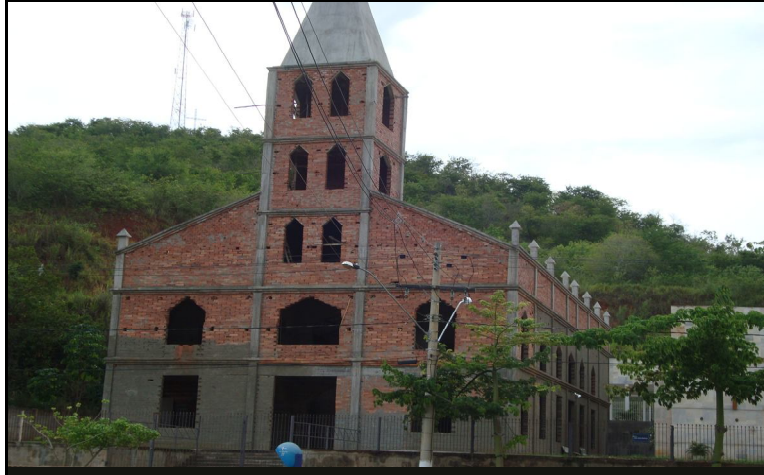
Figura 35: Construção da segunda igreja católica. Fonte: Priscila Costa (2010).
