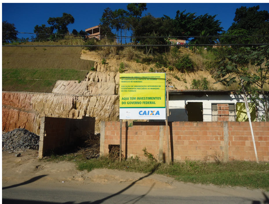
Figura 18. Obra de contenção de encosta Marcílio de Noronha. (Foto do Autor, maio de 2011)
