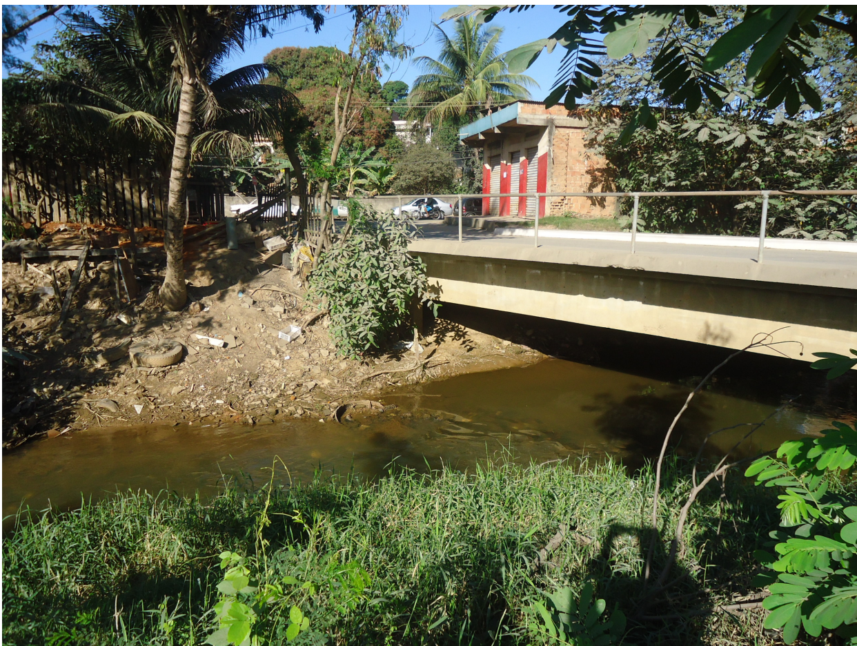
Figura 21. Vista da ponte que liga bairro Operário (Cariacica) com Industrial (Viana). Foto do Autor (maio de 2011).
