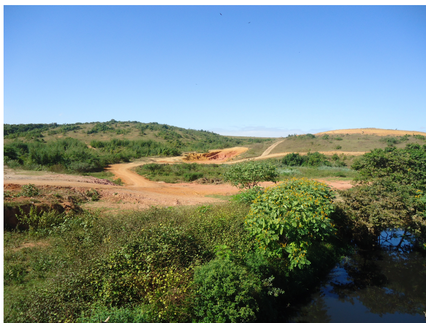
Foto 40. Corte de encostas e de estradas às margens do rio Formate. Foto do autor (maio de 2011).
