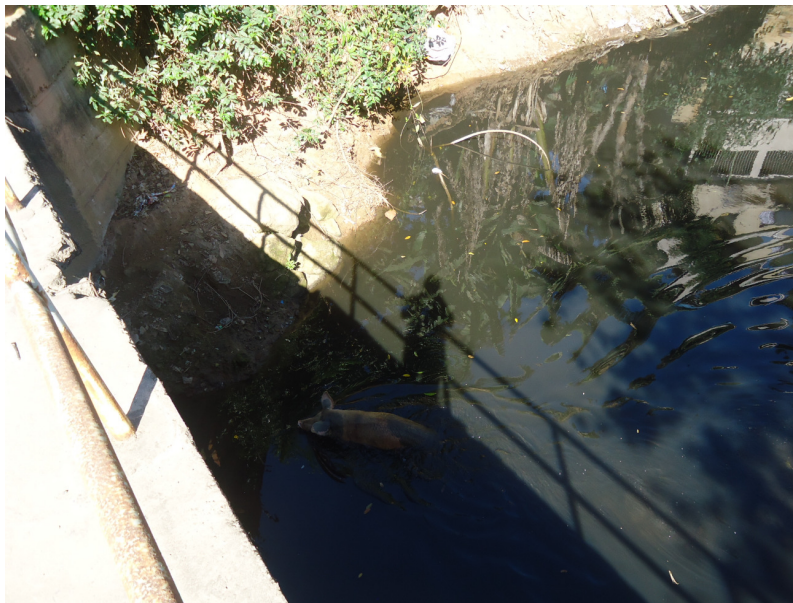
Figura 36. Ponte sobre o rio Formate em Vila Rica (Cariacica). Foto do autor (maio de 2011).
