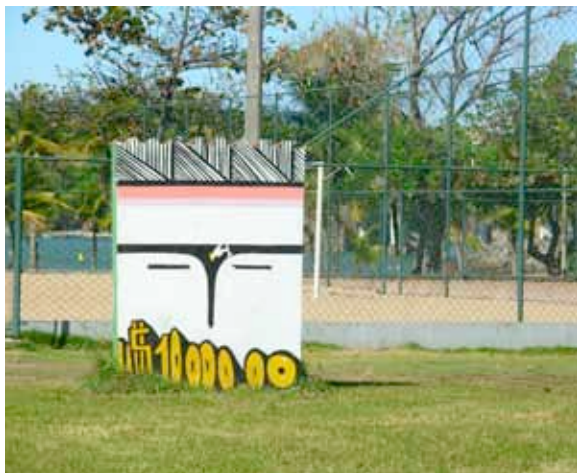
Fig. 109 – Caixa de energia, praça dos Namorados [E.24]
