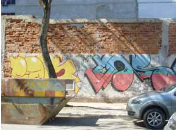
Fig. 76 – Muro antes da reforma [C35]
