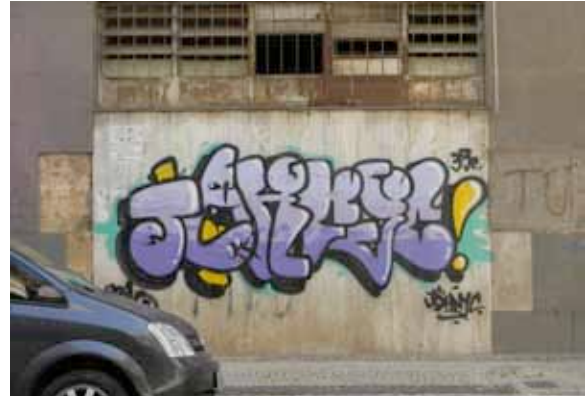
Fig. 88 – Prédio que pertenceu ao INSS, hoje abandonado [C.07]
