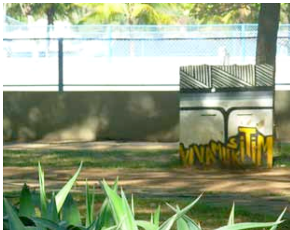
Fig. 110 – Caixa de energia, praça dos Namorados [E.27]
