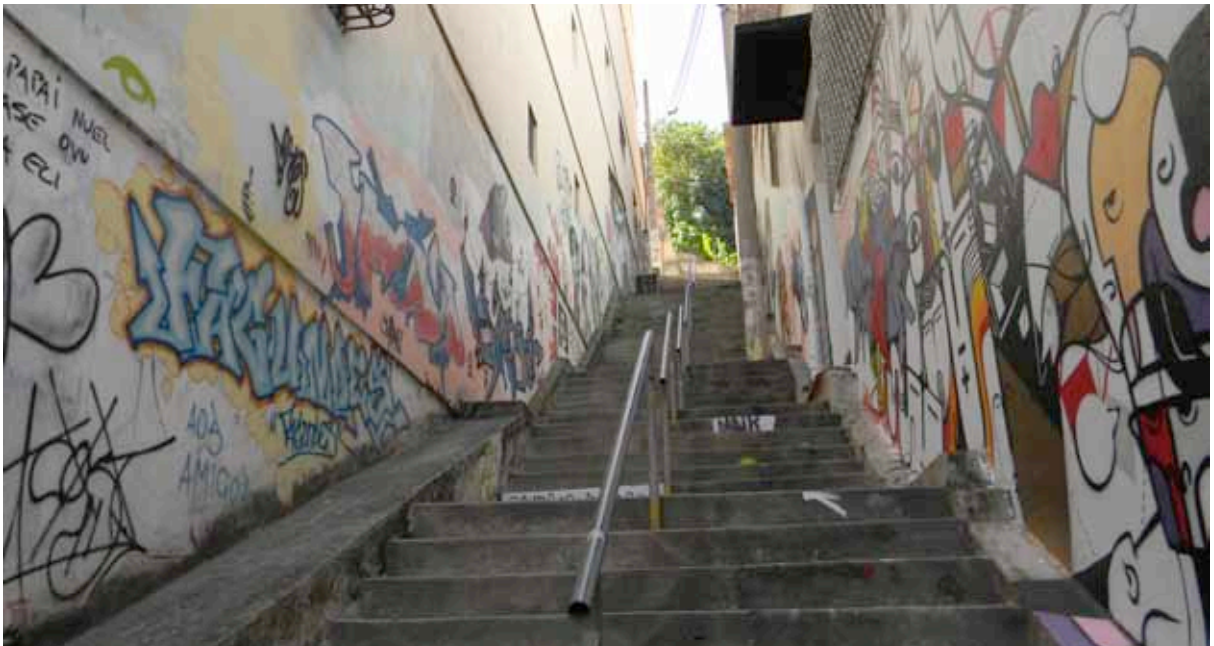
Fig. 78 – A escadaria com antigas e novas intervenções [C.38]
