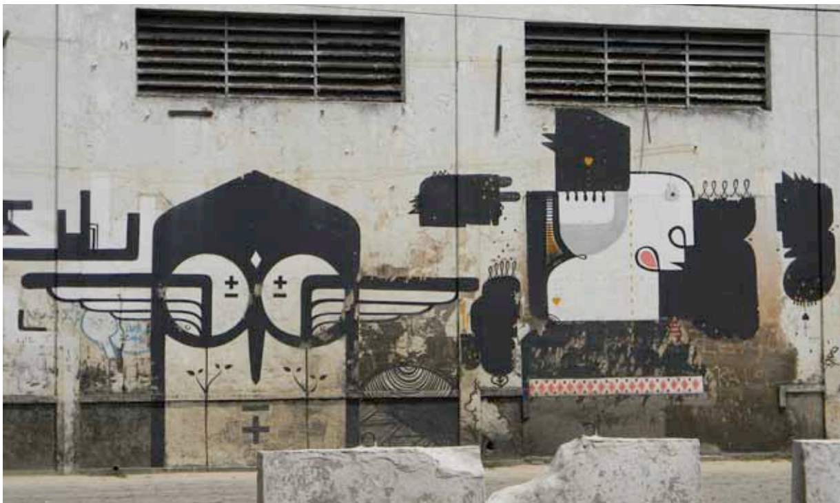
Fig. 130 – Detalhe da fachada de galpão abandonado em Goiabeiras [JP.28]
