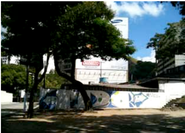
Fig. 89 – Muro de edificação que abriga serviços da prefeitura [C.46]
