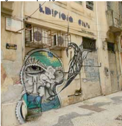
Fig. 81 – Fachada [C.22] de casarão abandonado grafitado
