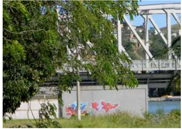
Fig. 84 – Graffiti localizado no pilar da Ponte Florentino Avidos [C.03]
