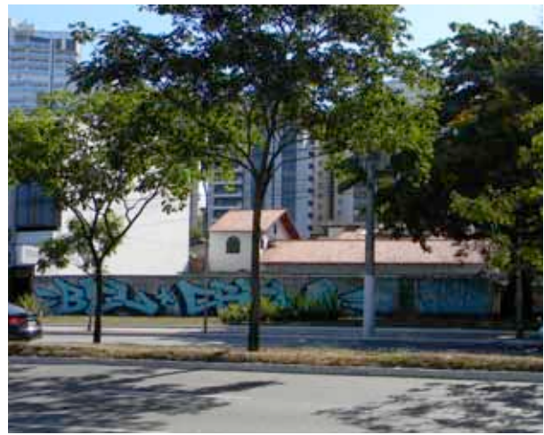
Fig. 108 – Muro abandonado [E.18]
