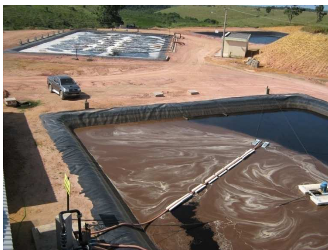
Figura 4. Lagoa anóxica com formação de biomassa suspensa e ao fundo da imagem a lagoa aerada.
