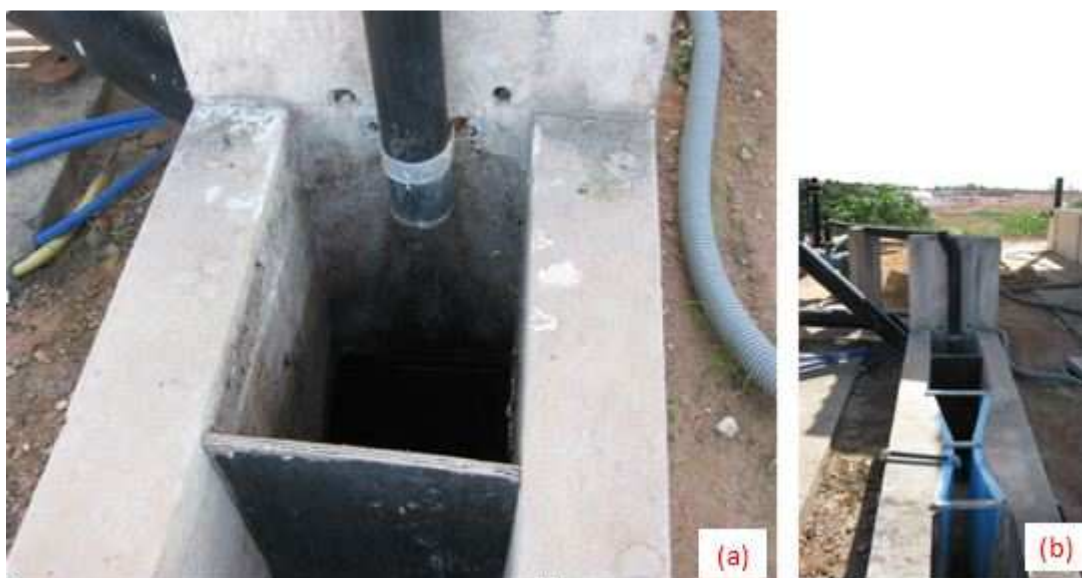
Figura 8. Ponto de coleta das amostras (a) na entrada da tubulação na calha Parshal (b).
