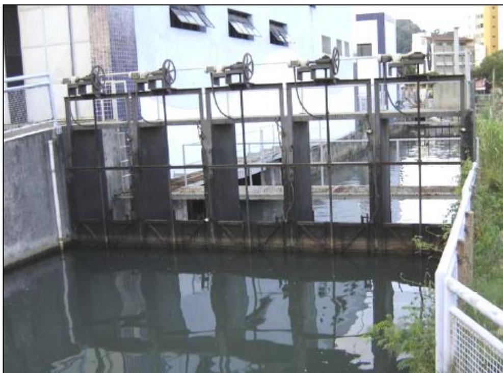
**Figura 25 - Comportas para retenção do fluxo da maré (em situação fechada), localizada na galeria do Bairro Bento Ferreira, à Rua Jair Etiene Dessaune. Registro fotográfico obtido às 16h00min do dia 02/03/2010, 11 minutos após a preamar**
