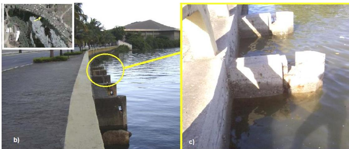
Figura 27 - (a) Localização, (b) vista *in situ* do ponto de descarga, no Canal Principal da Baía de Vitória (junto à Ilha da Fumaça), da galeria de drenagem do Bairro Bento Ferreira, zona Sul da Ilha de Vitória 30 minutos após a baixa-mar prevista para o dia 19/03/2011 e (c) imagem da mesma galeria completamente inundada 10 minutos após a preamar prevista para dia 19/03/2011
