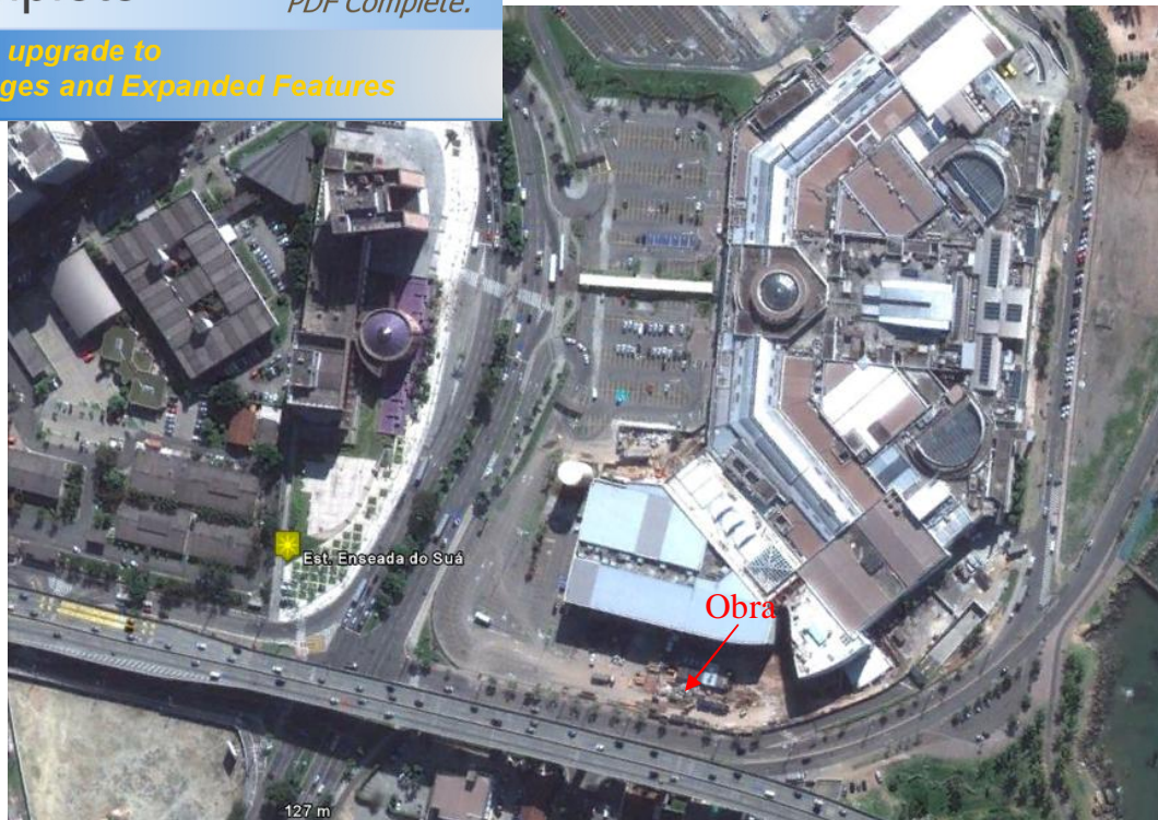
Figura 6-16 ó Detalhe da obra que ocorreu no Shopping Vitória durante o período de amostragem.
