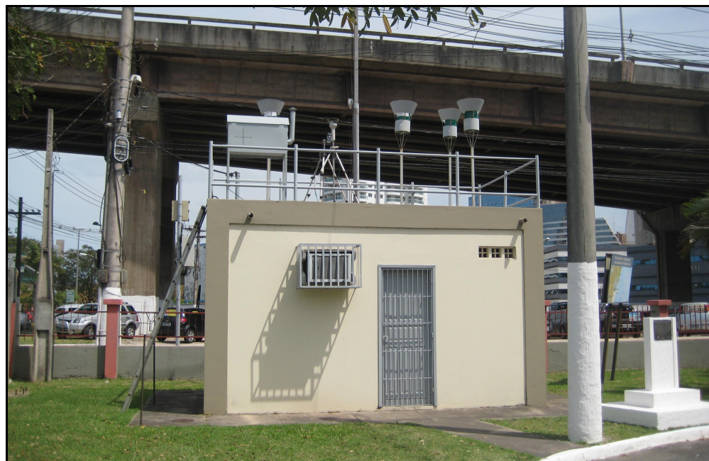
Figura 5-11 ó Aspecto físico da estação de monitoramento na qual o equipamento de amostragem foi instalado.
