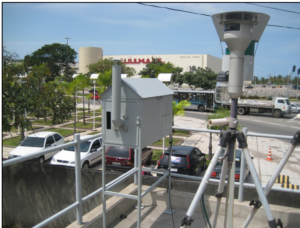
Figura 5-13 ó Detalhe da parte superior da estação de monitoramento e posição do abrigo do Handi-vol.
