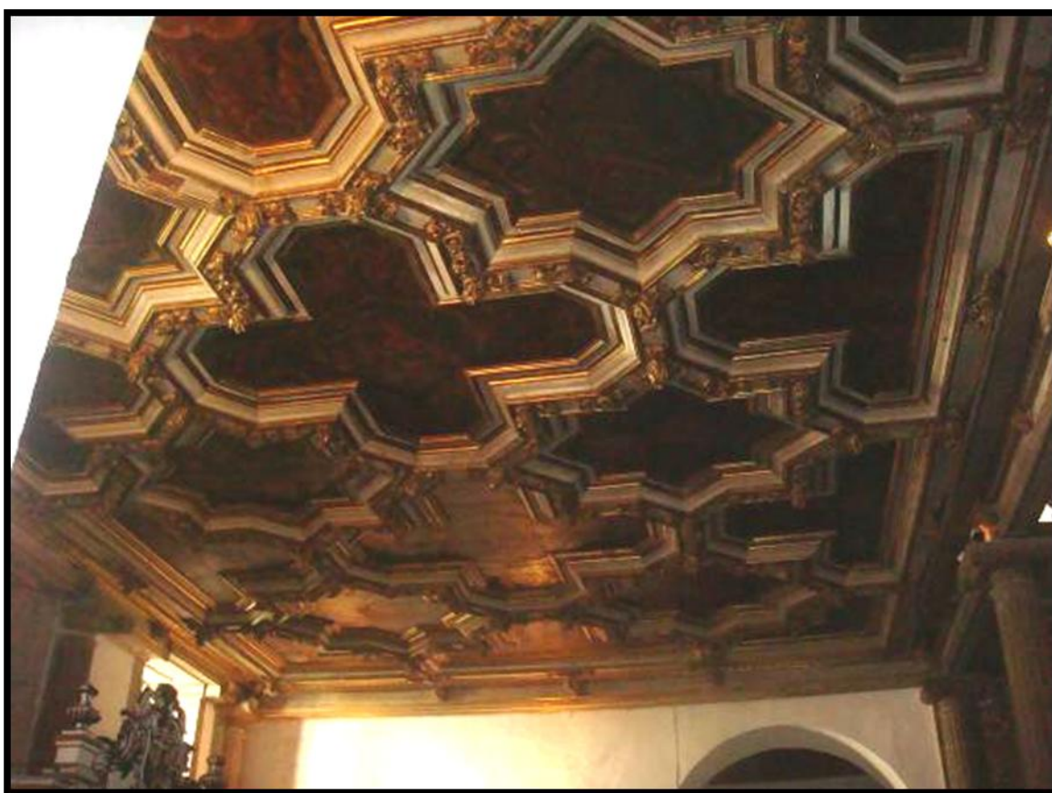
Figura 238 - Forro do nártex. Foto do autor.
